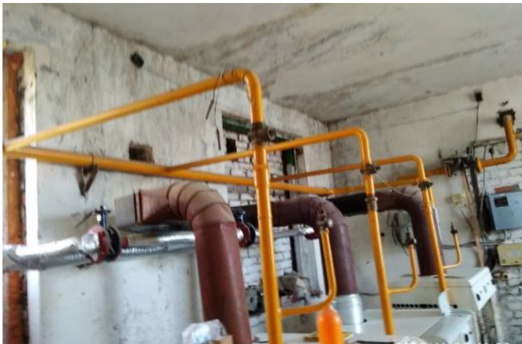
Рисунок 1.1.2.4 – Газоходы котельной
