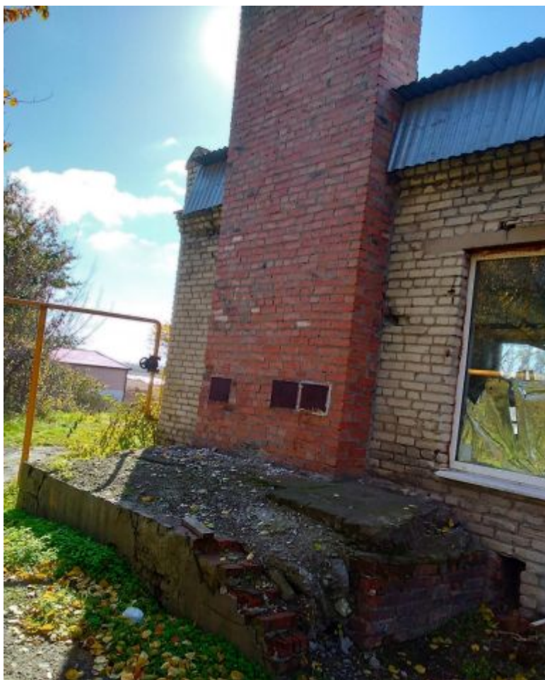
Рисунок 1.1.2.2 – Внешний вид здания котельной (дымовая труба)
